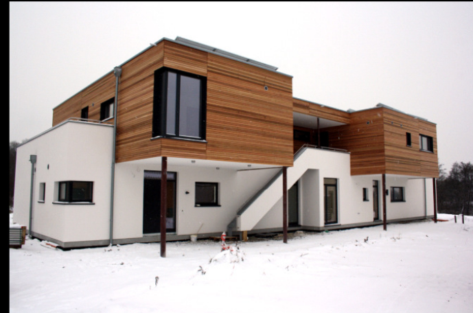
BÜROGEBÄUDE - ALFRED-KLANKE-STR.7 - SCHWERTE-VILLIGST
